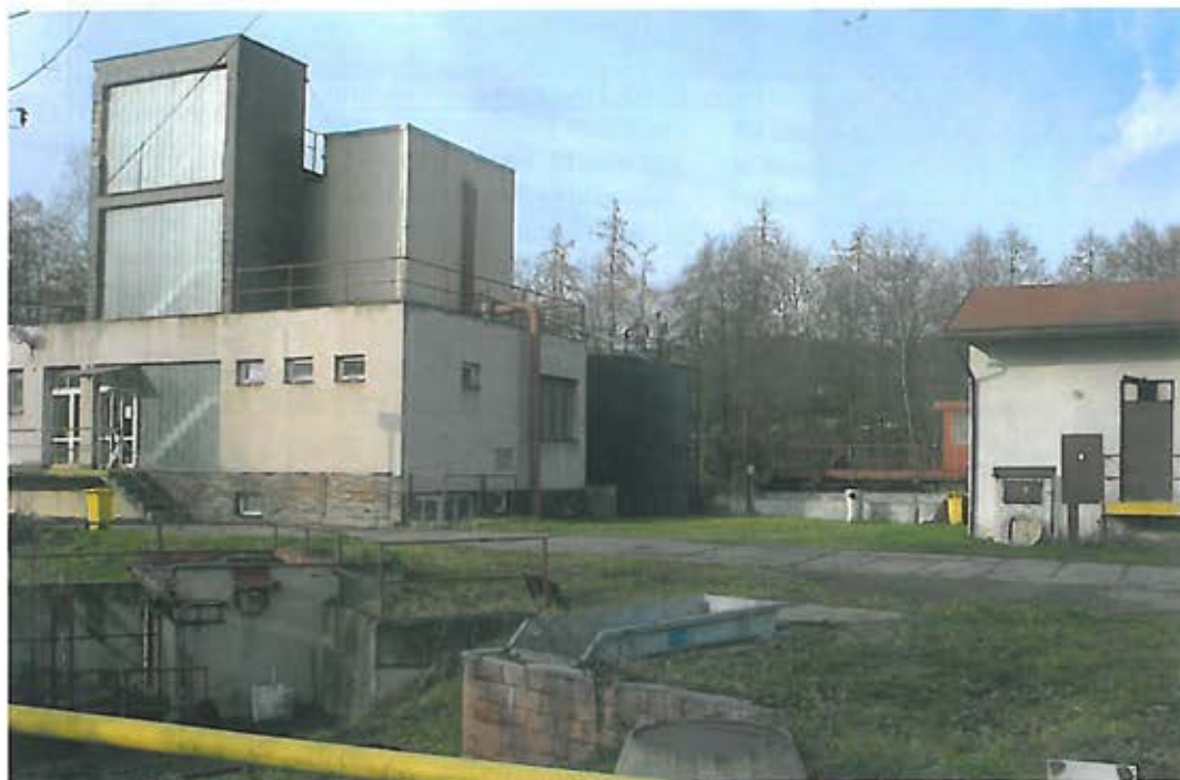
Areál čistírny odpadních vod ve Vilémově. Foto : Zdeněk Hauser
